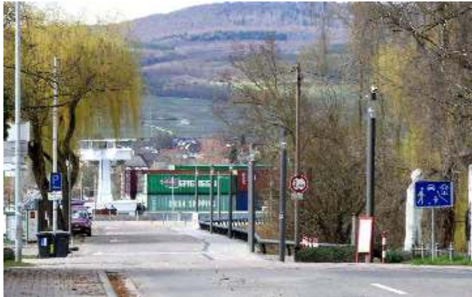
Rheinstraße Bremschwellen Richtung Fähranleger
